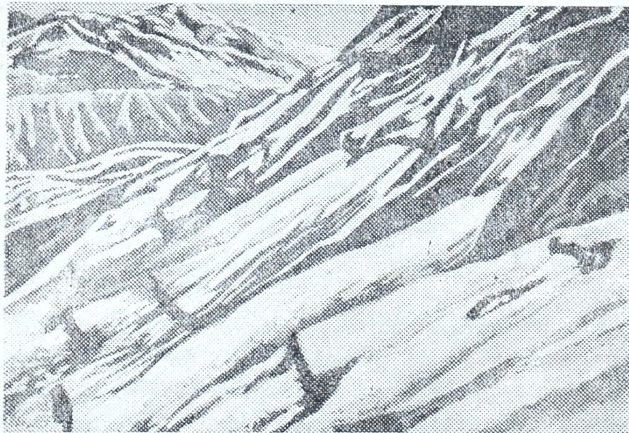
ნახ. 14. შვავების საწინააღმდეგო კედლები მთის ციცაბო კალთებზე შვეიცარიაში.
