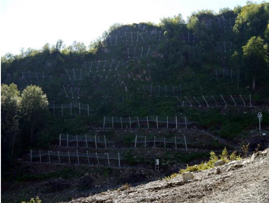
სურ. 6.6. ზვავის შემაკავებელი ნეილონის ბადე
