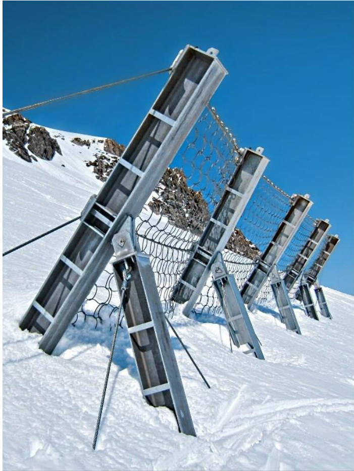
ნახ. 6.7. ზვავის შემაკავებელი ბაღე
