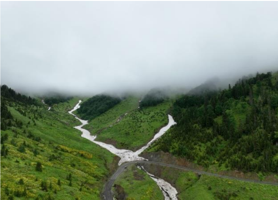
ნახ.2.3.4 ჩოხატაური-ბახმაროს საავტომობილო გზის მდ. საშუალაზე გადასასვლელი გზის მონაკვეთზე ჩამოსული ზვავი (2023 წ ივნისი)
