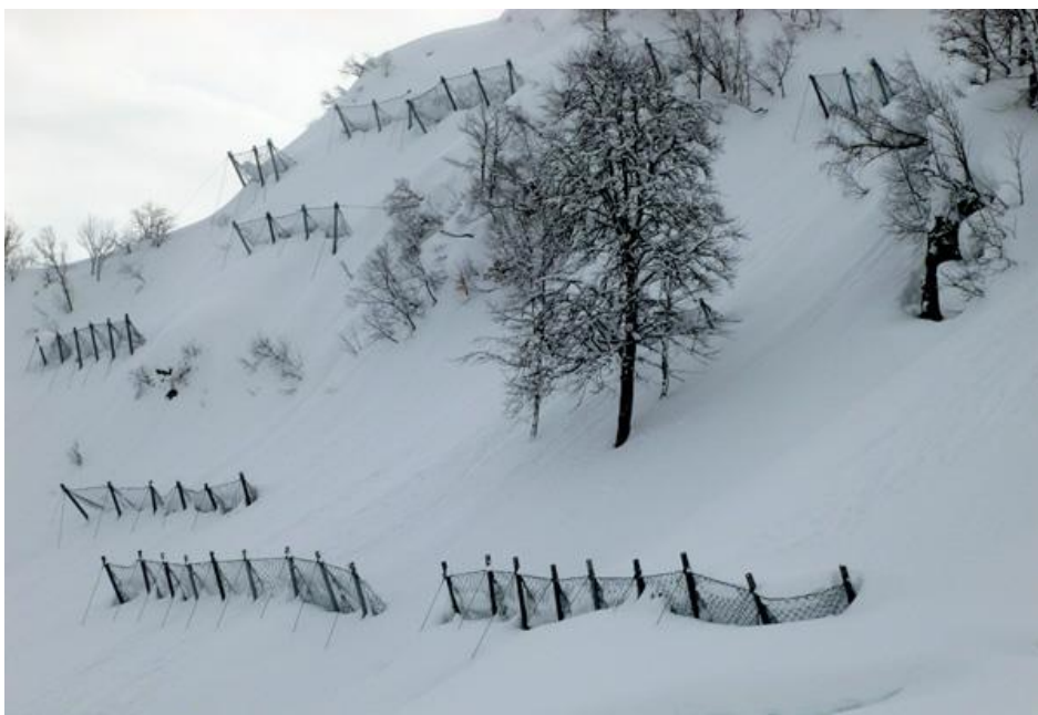
სურ. 6.5. ზვავის შემაკავებელი ალუმინის ბაღე
