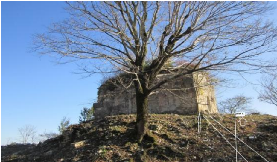
ნახ. 7. ნახაზზე დატანილია პროფილების გატარების მიმართულებები და დასახელებები, იხ. ნახ. 1, უბანი-D, ისრით მითითებული შენობის კუთხის GPS კოორდინატებია :0736017; 4693635.
